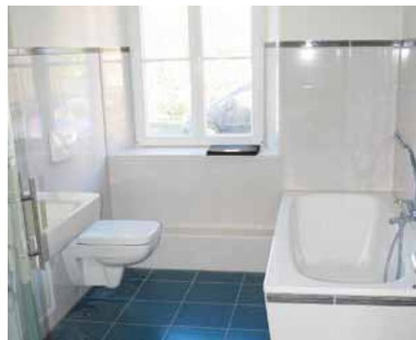
Fotos oben: Friedrich-Adolph-Sorge-Straße 14 – vor und nach der Sanierung
